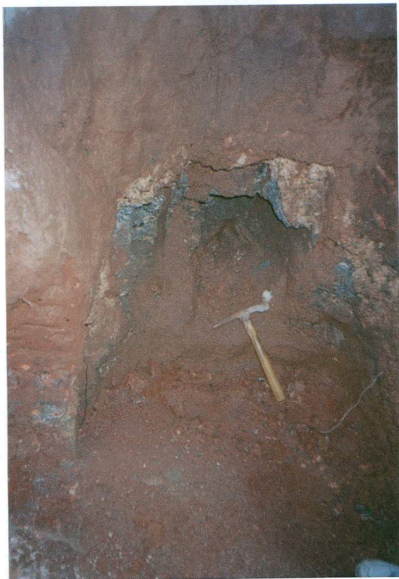
Figura 51 – Parede da trincheira aberta no ponto C1P3, localizado na porção lateral inferior da cicatriz. Nota-se a forte presença de blocos e de um material extremamente grosseiro. O martelo da figura se encontra a 1,0m de profundidade.
