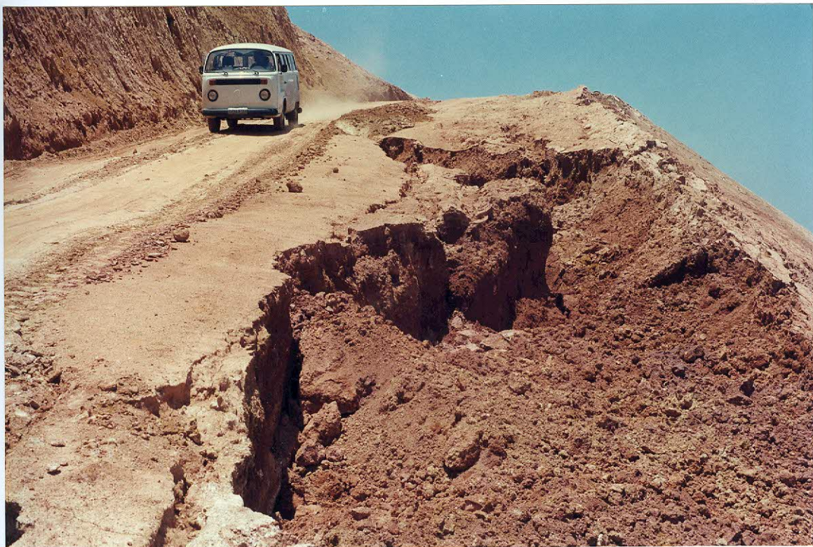
Figura 33. Movimentação de terra na saibreira da localidade Vale do Paraíso.
