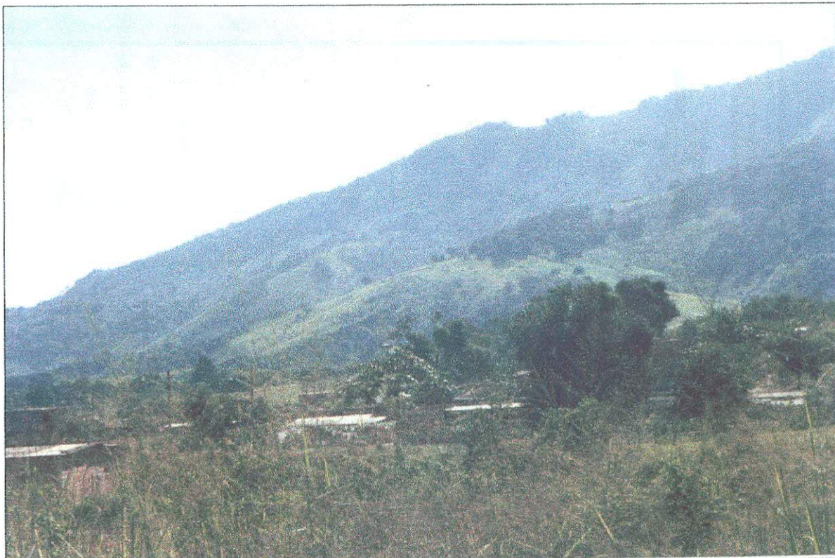
Figura 22: Alteração da vegetação, plantio de bananeiras e pressão urbana na encosta a leste do Mendanha.
