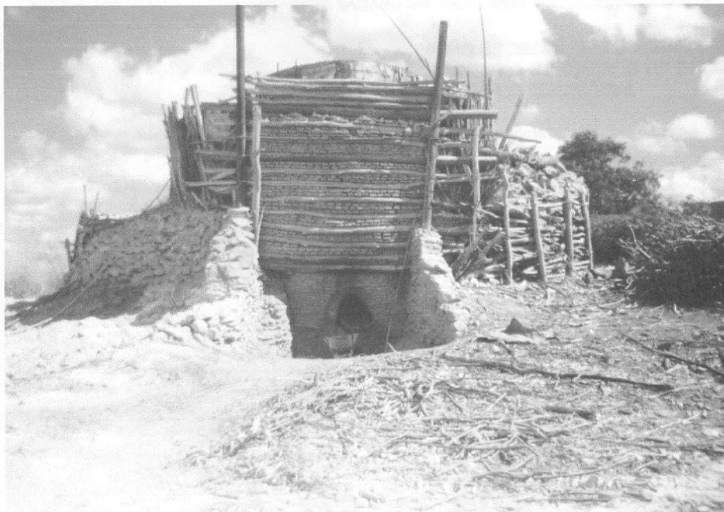
**Figura 16.** Vista geral de uma caieira rudimentar construída com blocos de rocha e madeira retorcida amarrada com cabos de aço (out/2007).
