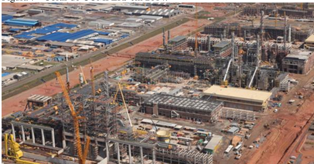
Figura 7 - Obras do COMPERJ em 2014.
