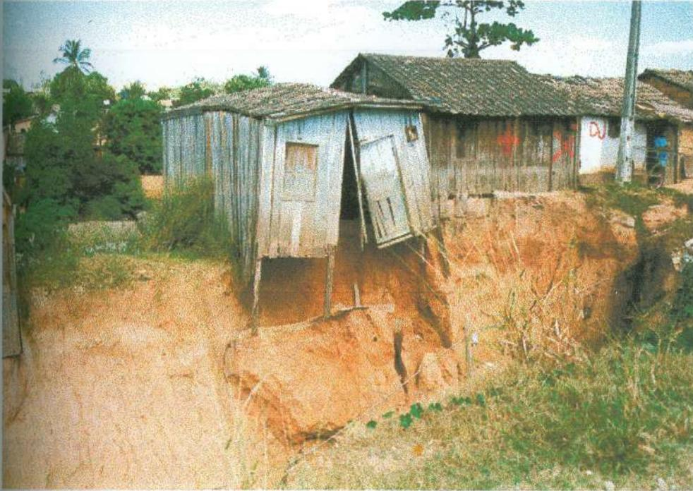
Figura 59 – Casa condenada na voçoroca do Jacu devido ao desabamento causado pela erosão. A casa ao lado marcada com "X" vermelho está condenada pela Defesa Civil. Foto: Elis Miranda. Julho/97.
