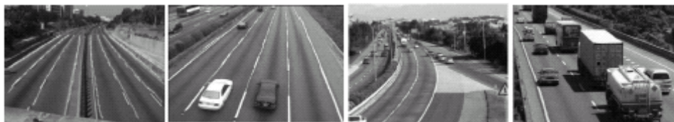
Figura 33: Pistas com faixas múltiplas.
