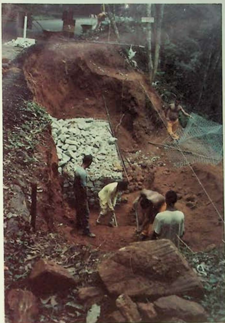
Foto 7 - Colocação de gabiões
