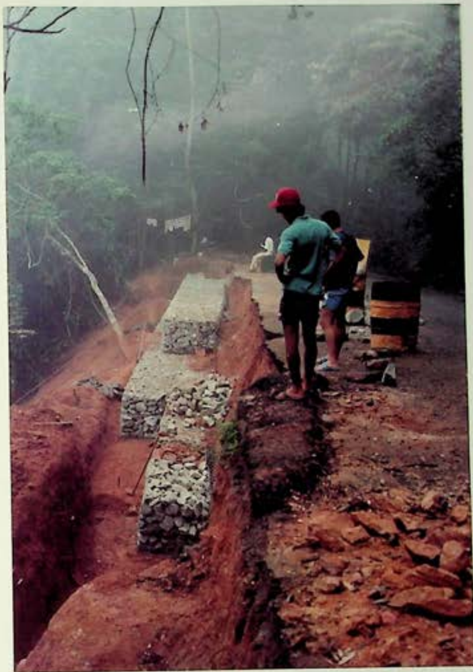
Foto 6 - Colocação de gabiões.
