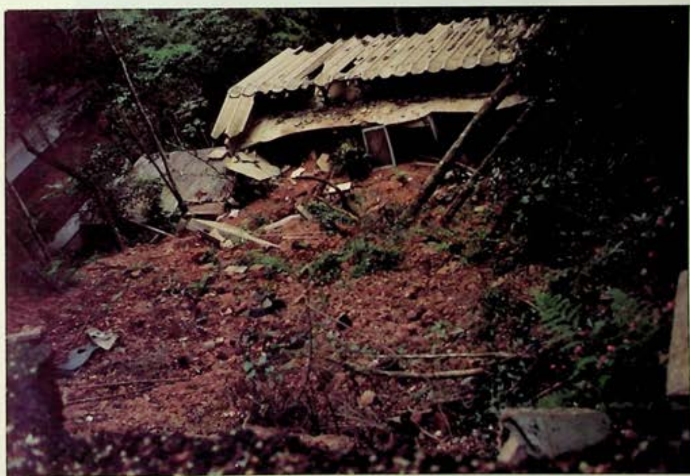
Foto 5 - Escorregamento abaixo da estrada com destruição parcial de residência.
