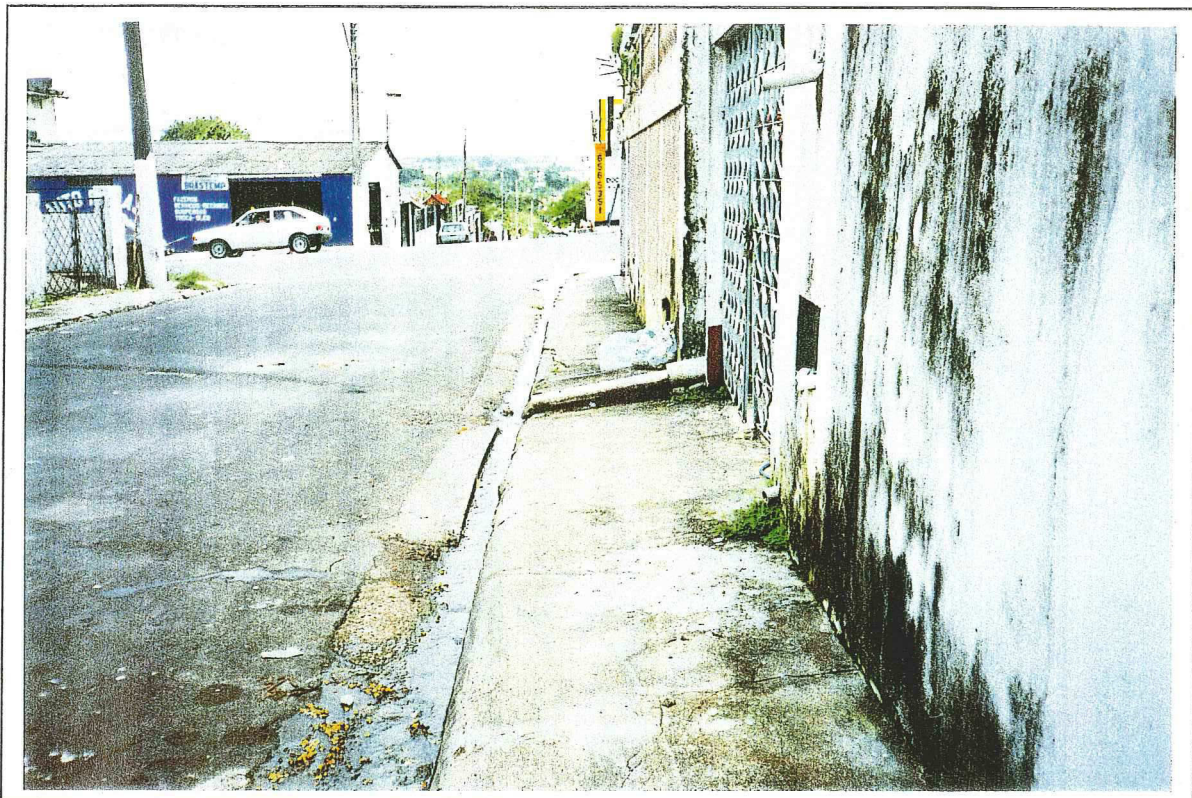
Foto 6 - Conjunto D. Pedro - esgoto doméstico correndo na via ao lado da calçada, rua Mém de Sá - Foto do autor, fevereiro de 1996.
