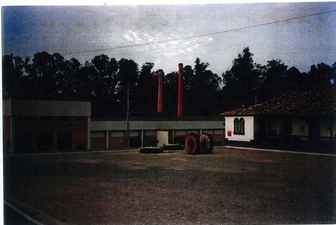
Foto 1: Aspectos da unidade industrial CEDRO, a 1ª indústria têxtil de Minas Gerais, vendo-se ao fundo as duas chaminés centenárias da edificação original e as novas edificações que substituíram as antigas; o prédio colonial, parcialmente avistado à direita, refere-se às antigas instalações administrativas, que hoje abrigam o museu têxtil Décio Guimarães, único em Minas Gerais. (Caetanópolis, Agosto de 2002, Marly Nogueira)
