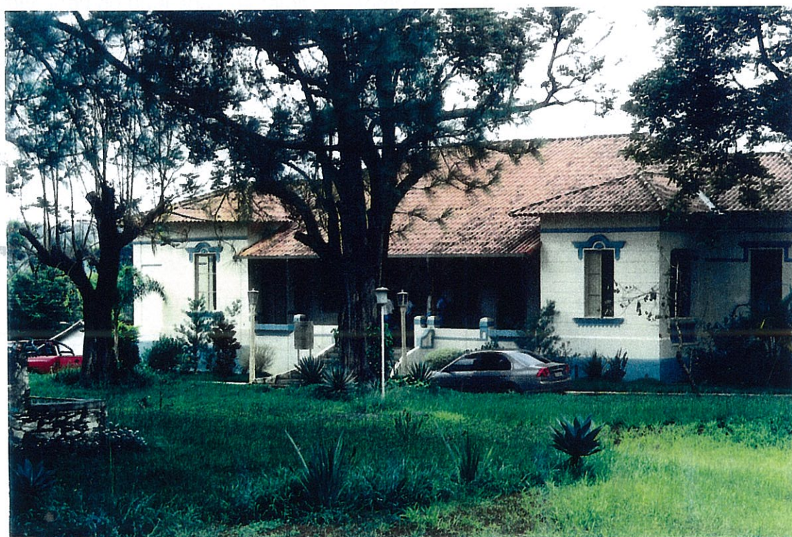
Foto 8: Prédio sede do CTCO, bela construção que, na origem, correspondeu à casa principal da fazenda, cujas terras hoje pertencem à Epamig. (Prudente de Moraes, Janeiro de 2003, Marly Nogueira)
