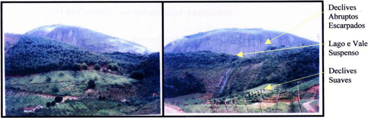
Figura 47 - Vista dos Subsistemas Declives Abruptos (S2.1) e Declives Suaves
