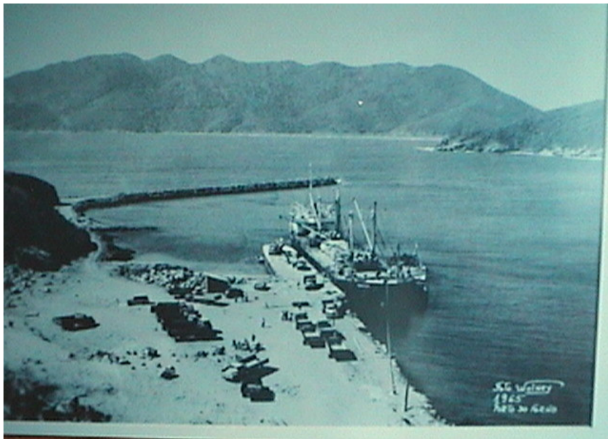
Figura 11. Modernização do Porto do Forno (1965), Arraial do Cabo, RJ. Presença do quebra-mar, protegendo o local de atracação dos navios. Fonte Arquivo da Divisão de Cultura; acervo da Prefeitura Municipal de Arraial do Cabo; fotógrafo Ronaldo Miranda Fialho.
