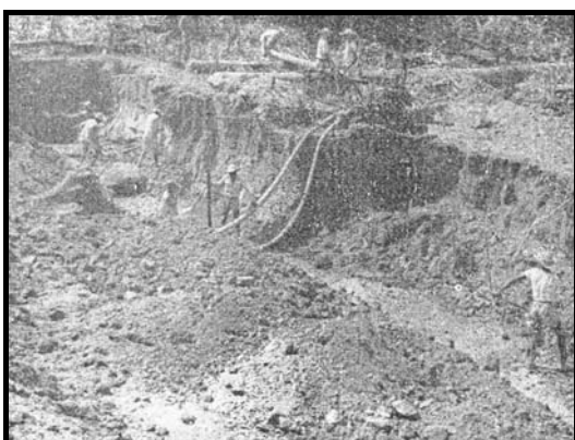
Figura 15 - Desmonte e lavagem do cascalho no Igarapé Cabo Sobral - Tepequém/RR. Fonte: GUERRA, 1957
