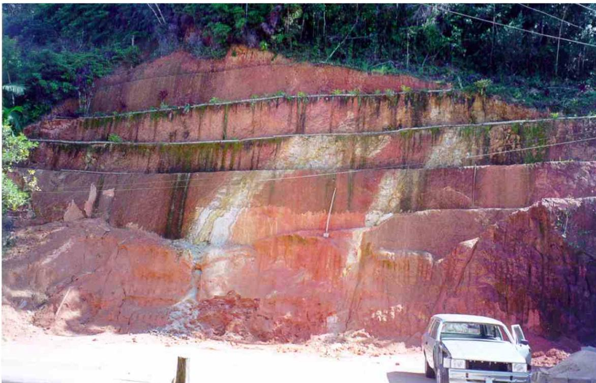
Foto 4.2 – Corte de encosta no distrito sede de São Pedro de Alcântara, observar os veios quartzo – feldspáticos e a ruptura da bancada que ocorreu principalmente junto destes veios. A textura é arenosa nos veios e siltosa no restante do material. (Foto José Luís B. Gardenal – jan./2000).
