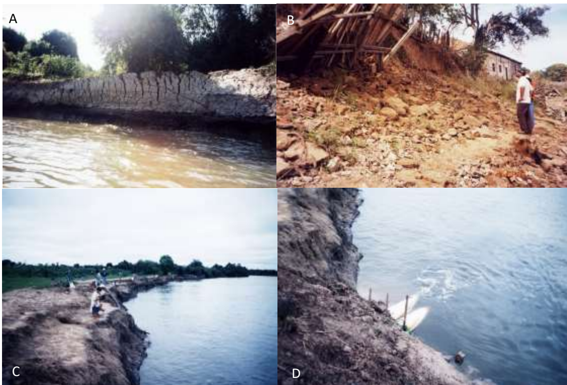
Figura 4 – (A) Efeito do atrito das grandes embarcações (comboios) nas margens (B) erosão das margens do rio Paraguai, no perímetro urbano (C) pesca de barranco e erosão nas margens (D) lançamento de esgoto.
