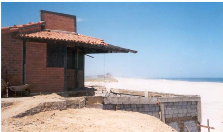
Foto 9 – Praia de Guaratiba. Este quiosque teve o deque completamente destruído. Na foto observa-se a sua recuperação.
