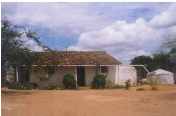
Foto 14 - Residência de pequeno proprietário em Japecanga de Caruaru. Outro exemplo de captação de água de chuva do telhado e armazenamento em cisterna. Maio de 2003, foto do autor.
