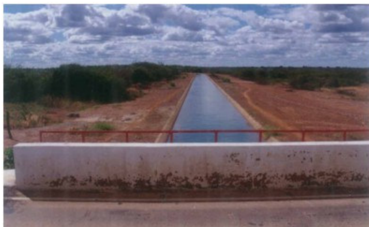
Foto 47 - Canal principal do sistema de irrigação do projeto de reassentamento Caraibas em Sta Maria da Boa Vista, julho/2003, foto do autor.
