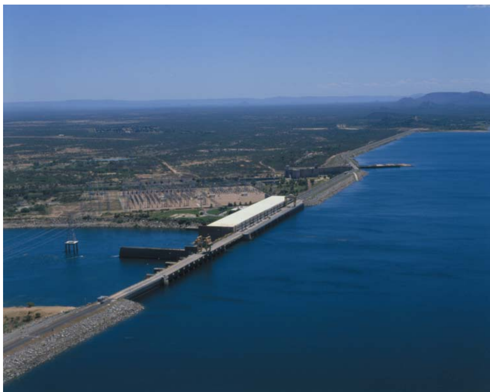
Foto 16 - Hidrelétrica de Sobradinho
