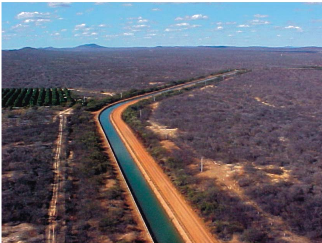
Foto 6 - Projeto de Irrigação Senador Nilo Coelho. Vista do canal principal na altura da represa de Sobradinho, atravessando grande área de caatinga arbustivo-arbórea. Fonte: CHESF
