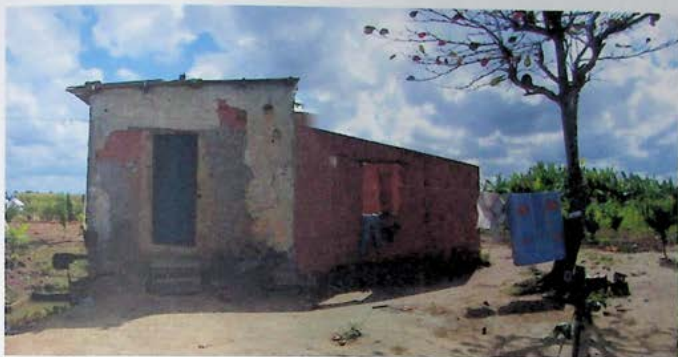
Foto 18: Alteração na forma antiga: ampliação de casa onde estavam instaladas bombas da Usina São João, hoje moradia de família assentada
