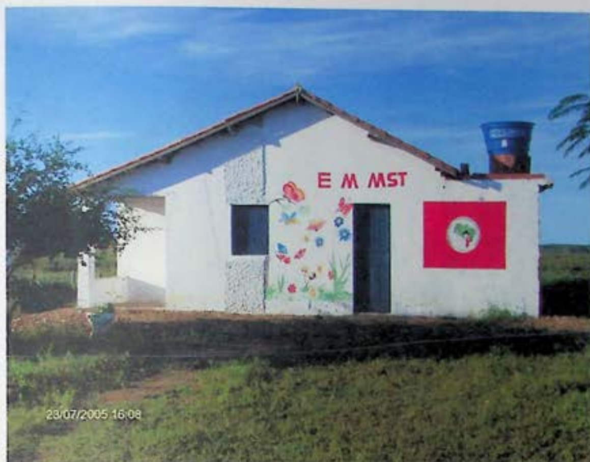
Foto 19: Alteração na forma antiga: ex-casa de operário da Usina São João, atualmente escola municipal de Cajueiro
