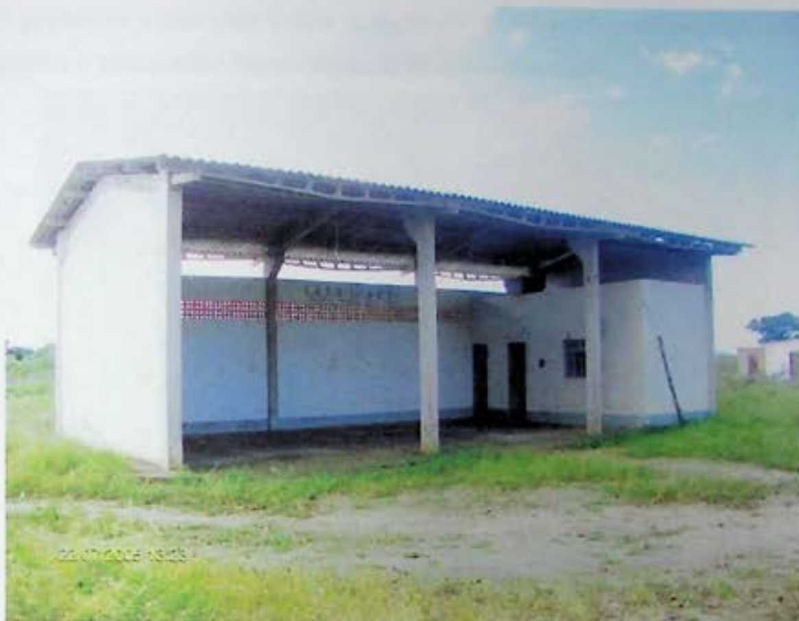
Foto 13: Nova forma: galpão construído pelo INCRA em todos os núcleos – funções diferentes das que foram previstas
