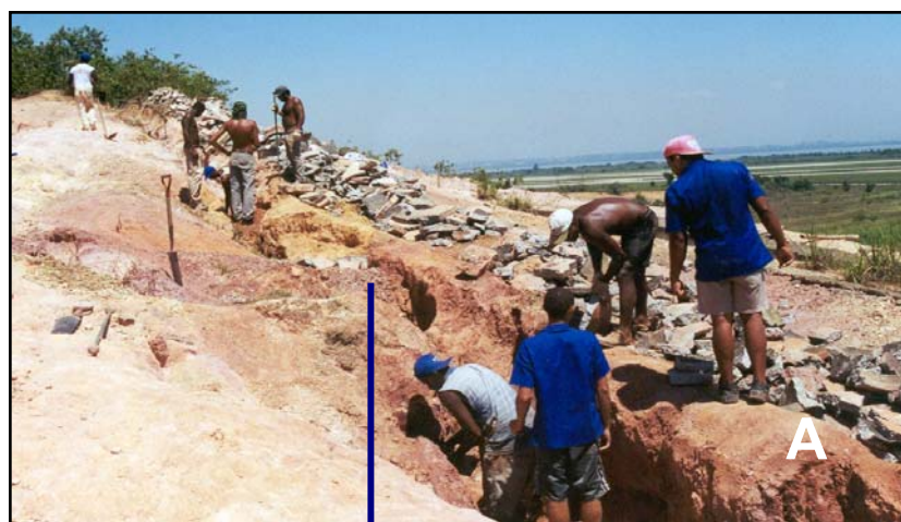
Figura 4.4. Bacia de captação – abertura de covas para plantio no talude de aterro das bacias de captação
