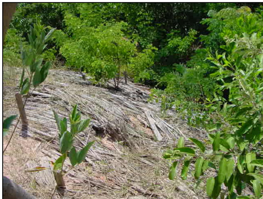
Figura 6.70. Proximidades das estações Bt11 e Bt12, anteriormente à instalação das baterias de tensiômetros. Observa-se que a vegetação foi implantada posteriormente no talude de corte em relação ao talude de aterro logo abaixo.
