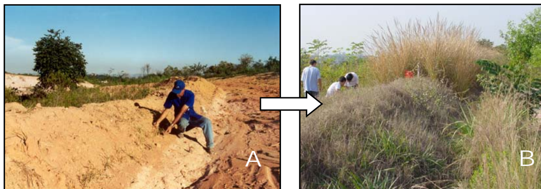
Figura 4.6. Terraços construídos com o material raspado pelo trator de esteira, antes (A) e depois (B) da revegetação com grama barbante e capim vetiver.
