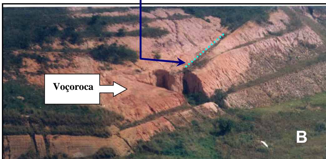
Figura 4.5. Processo de construção do cordão vegetado a oeste da voçoroca. Acima o enterramento dos restos da canaleta (A). Abaixo (B) a voçoroca vista num sobrevôo de helicóptero observando-se a localização da canaleta enterrada (seta e linha tracejada), e também alcovas de regressão na mesma face.
