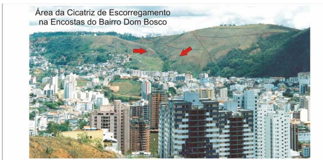
Figura 22: Fotografia representativa de uma área de cicatrizes nas encostas a montante do bairro Dom Bosco à jusante da estação meteorológica da UFJF.
