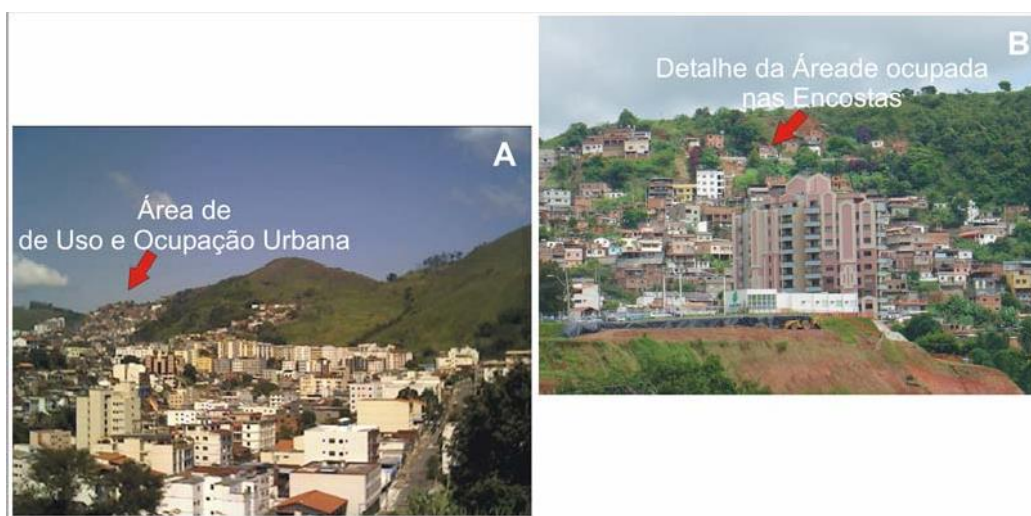
Figura 13: A fotografia A mostra parte do vale central com ocupação urbana e suas extensões em direção às áreas com maior ângulo de encosta. A fotografia B detalha uma parte da encosta representada na fotografia A, onde a ocupação urbana ganha densidade em áreas de declividade inadequada para tal tipo de ocupação.
