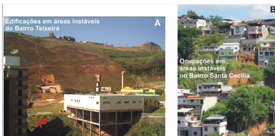
Figura 26: Representação das áreas de risco do Bairro Teixeira com suas edificações de classe média (Fotografia A) e do Bairro Santa Cecília com edificações mais pobres (Fotografia B).
