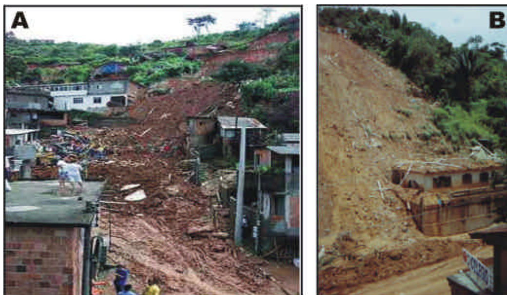
Figura 1.3- Processo de ocupação de encostas em Juiz de Fora (MG) (A) e Angra dos Reis (RJ) (B). Este tipo ocupação ocorre através de cortes ao longo da encosta aumentando a susceptibilidade de ocorrência dos movimentos de massa.
