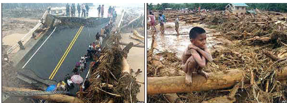
Figura 1.1- Danos causados por movimentos de massa e inundações ocorridos após intensas chuvas e um tremor de terra nas Filipinas em Fevereiro de 2006 (Foto de http://www.ig.com.br ).
