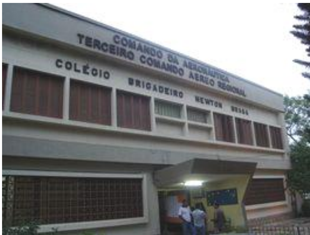
FIGURA 18 – COLÉGIO BRIGADEIRO NEWTON BRAGA, SITUADO NA ILHA DO GOVERNADOR, RIO DE JANEIRO - RJ
