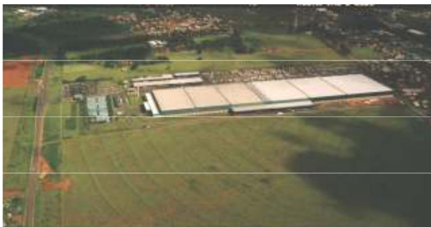
Figura 28 - Uberlândia: Central de Armazenagem e Distribuição da Arcom no Distrito Industrial, 2004. Fonte: Prefeitura Municipal de Uberlândia, 2004.
