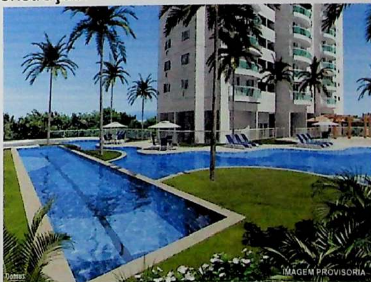
FOTO 3: FOTO ILUSTRATIVA DE UM DOS BLOCOS DO ACQUA RESIDENCIAL
