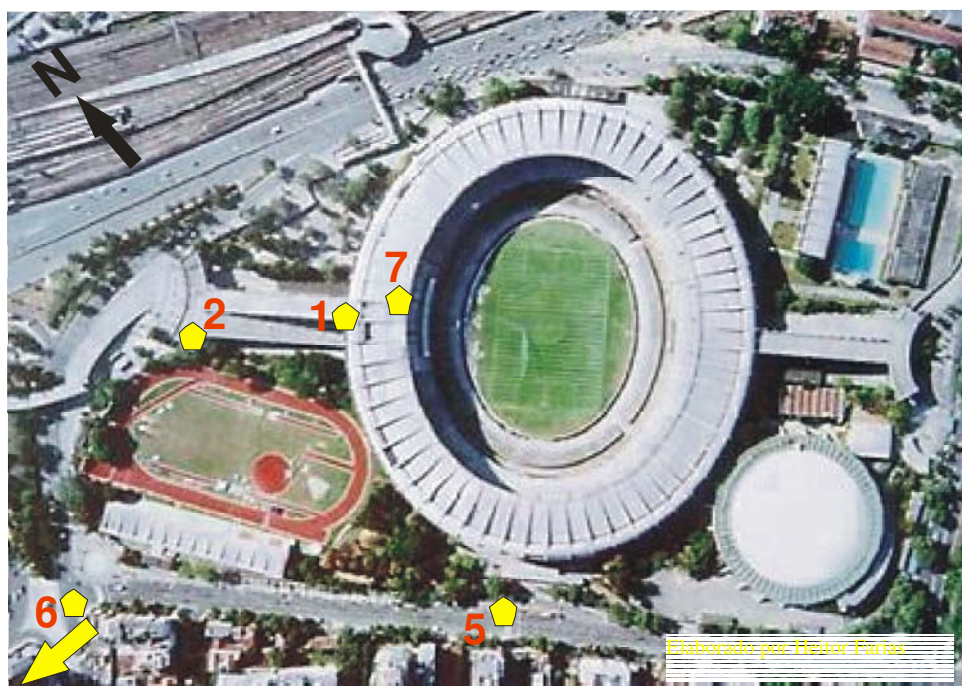
Figura 5.32 – Localização dos pontos dentro do estádio
