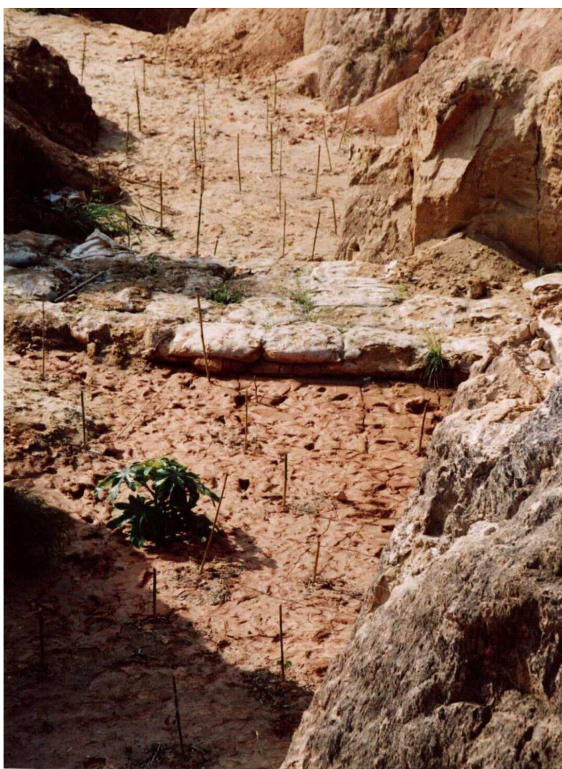
Fig. 21: Vista de um muro de saco construído no interior de uma voçoroca. Atentar para o fato da retenção excessiva de sedimentos à montante do mesmo. Foto: Gurgel Júnior, 2005.
