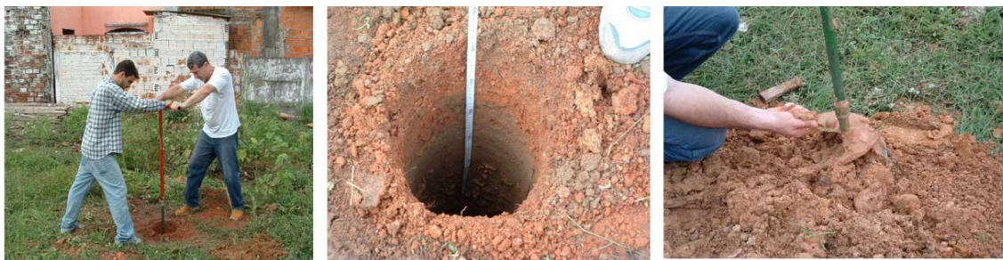
Figura 19. Etapas da execução da sondagem de solo com o trado helicoidal. Fotos do autor, 2003.
