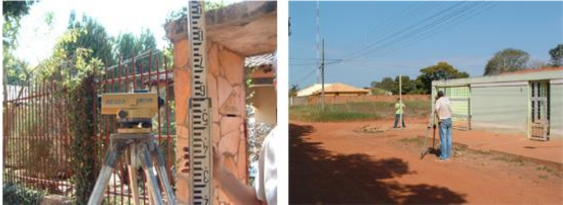
Figura 22. Levantamento topográfico com utilização de nível e baliza. Fotos do autor, 2003.
