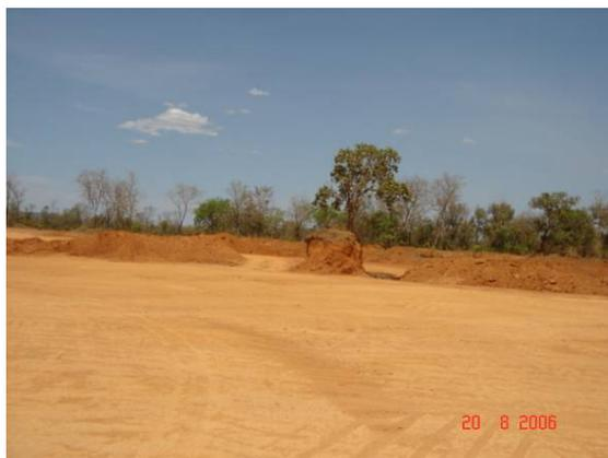
Figura 42 – Vista geral da cascalheira que cede material de recobrimento para o aterro sanitário de Palmas, Bacia do Ribeirão São João, em 2006, detalhe para o rebaixamento da superfície do terreno.
