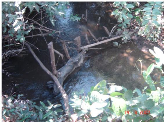
Figura 54 – 4º Barramento no Ribeirão São Joãozinho, realizado para atender ao sistema de irrigação convencional, detalhe para o estado precário de construção, municípios de Palmas e Porto Nacional.
