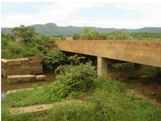
Figura 68 – Ponte nova no Ribeirão São João, nas proximidades da Cerâmica Betim, à esquerda da foto, a estrutura da antiga ponte.
