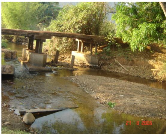
Figura 67 – Vista geral do assoreamento do Ribeirão São João; ao fundo, a estrutura da antiga ponte e a nova ponte (mais alta), “solução” dada pelos responsáveis pelo setor de transporte, que não consideraram a dinâmica fluvial.
