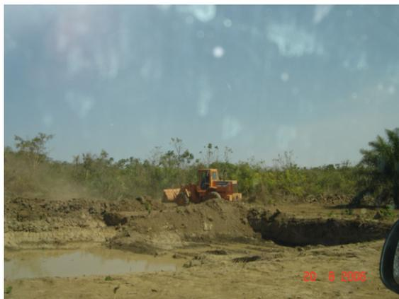
Figura 26 – Área de exploração de argila para abastecimento de uma cerâmica localizada na Bacia do Ribeirão São João e outras na circunvizinhança, destinadas à produção de telhas e tijolos, detalhe para a máquina escavadeira, Fazenda Vale do Ribeirão São João, município de Porto Nacional – TO.
