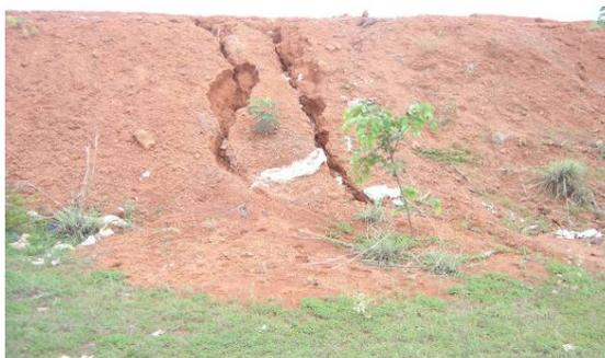
Figura 11 – Vista parcial do talude da parede do “Aterro Sanitário de Palmas”, detalhe para a instalação de processos erosivos.
