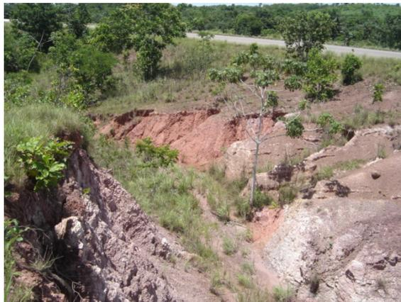
Figura 87 – Voçoroca verificada à margem da TO-050, no detalhe o processo ré montante que pode comprometer o leito da rodovia asfaltada, Bacia do Ribeirão São João, município de Palmas – TO.
