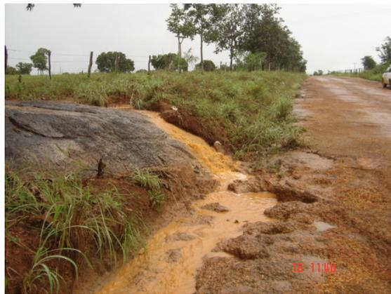
Figura 81 – Ravina na margem da principal via de acesso à Bacia do Ribeirão São João, detalhe para o afloramento da rocha granítica e o contacto abrupto rocha-solo, favorecendo a instalação de processos erosivos. Palmas – TO.
