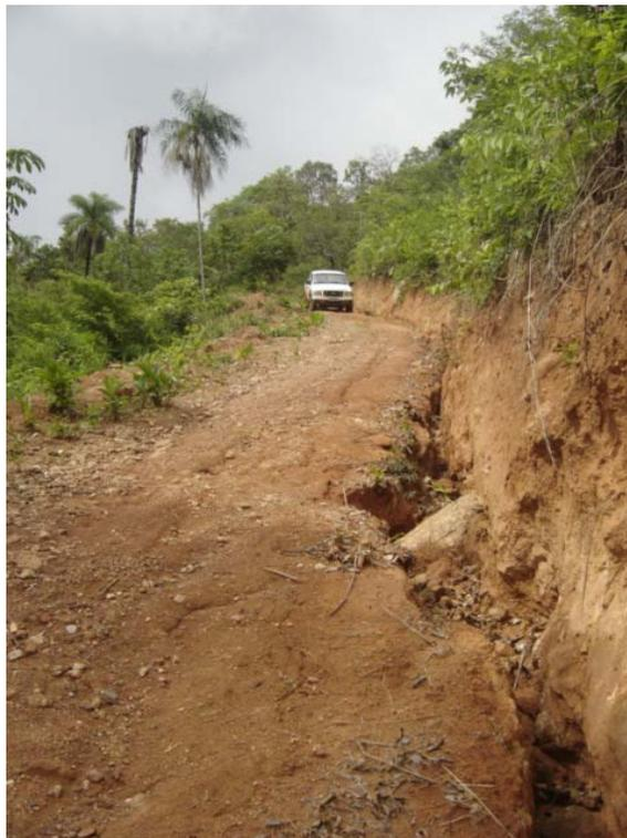
Figura 13 – Visão panorâmica da zona de morro e o processo erosivo acelerado no leito da rodovia que dá acesso à fazenda Vale do “Vai-Quem-Quer”
