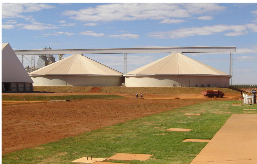
Figura 3: Silos de Armazenagem da SADIA
