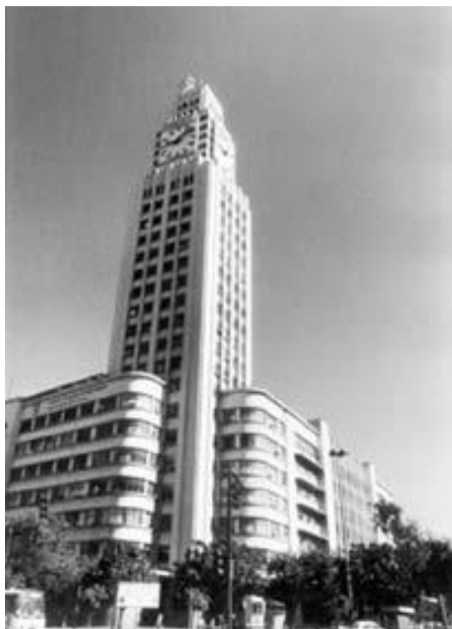
Figura 16: O novo edifício da Central do Brasil Fonte: O Globo
