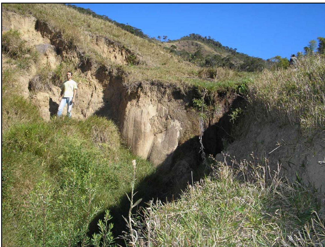
Figura 30. Voçoroca provocada por processo de exfiltração, na sub-bacia do Rio Sana (Foto. Lagesolos, 2007).
