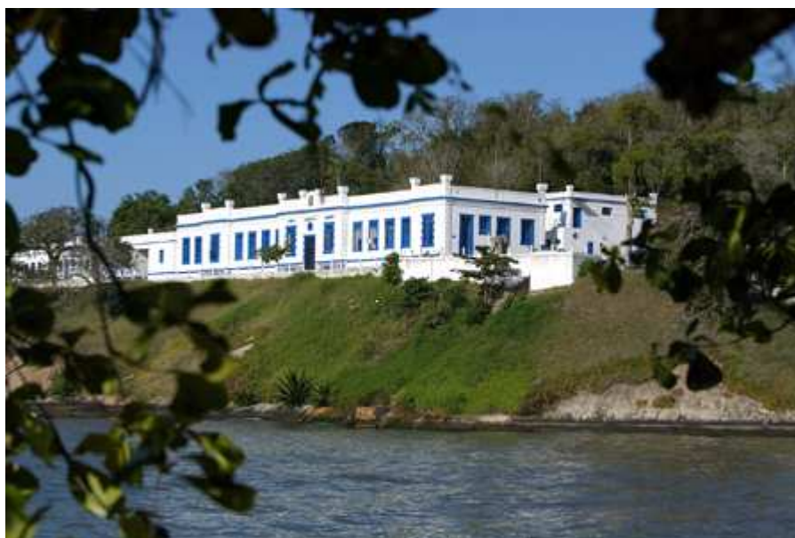
Figura 2 – Forte Marechal Hermes (arquitetura colonial, 1651) (Foto de Rômulo Campos e Cláudia Barreto, 13.08.2002)
