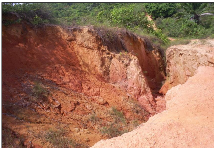
Figura 12: Processo erosivo em estrada na zona de amortecimento
