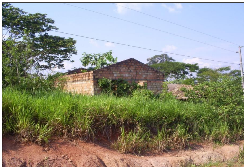
Figura 15: Casa de alvenaria não terminada
