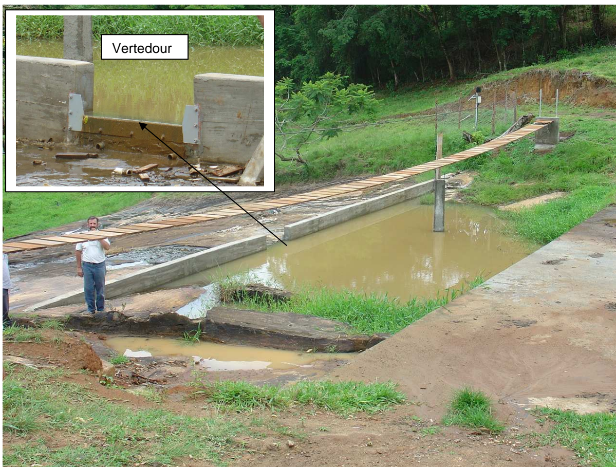
Figura 15: Delimitação da seção transversal de monitoramento de vazão e sedimentos na bacia do córrego Santa Maria, no Noroeste Fluminense. Foto: FERNANDES (2005).
