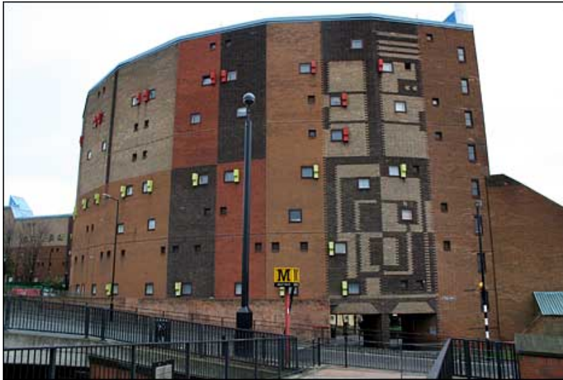
Figura 22: conjunto Byker de Ralph Erskine
