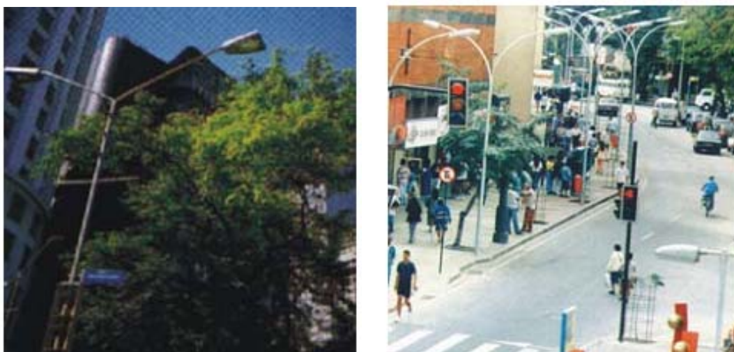
Figura 28 - Poste multiuso que permite que em uma única estrutura esteja presente uma iluminação com dois focos, sendo um voltado para via e outro para o passeio.
