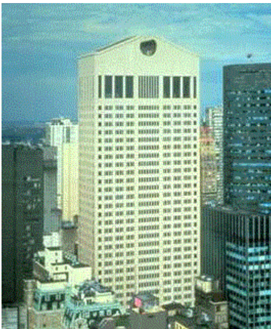
Figura 11 - Edifício da AT&T
