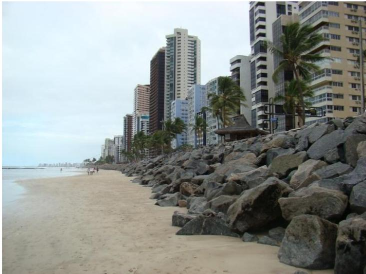
**Fig. 25** –Enrocamentos para contenção da erosão na praia de Boa Viagem, Recife (PE)
