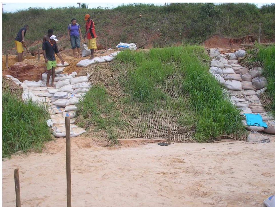
Figura 24 – Manutenção dos trabalhos de reabilitação. Foto: Bezerra, 2008.
