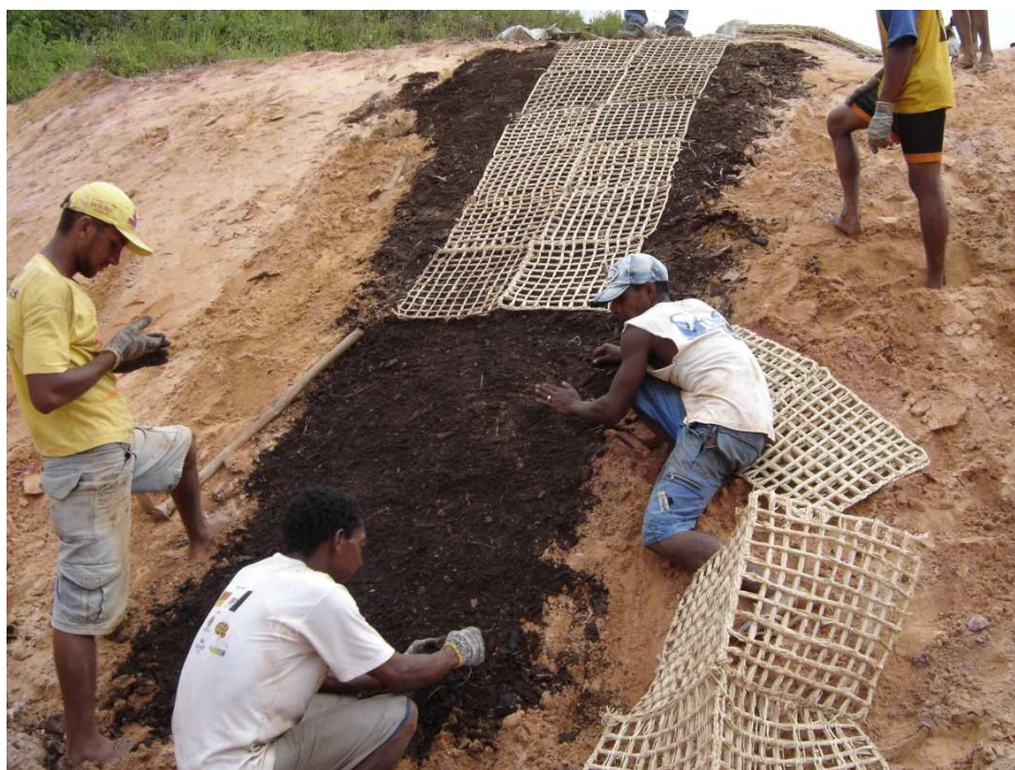
Figura 23 – Aplicação dos geotêxteis e insumos. Foto: Bezerra, 2008.
