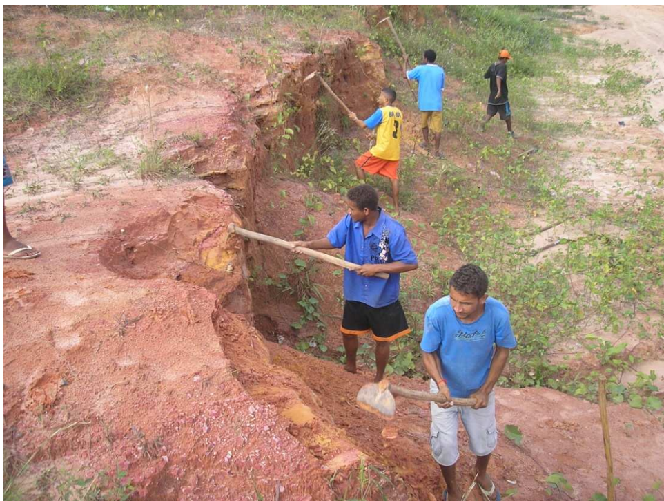
Figura 22 – Retaludamento com trabalho manual. Foto: Bezerra, 2008.
