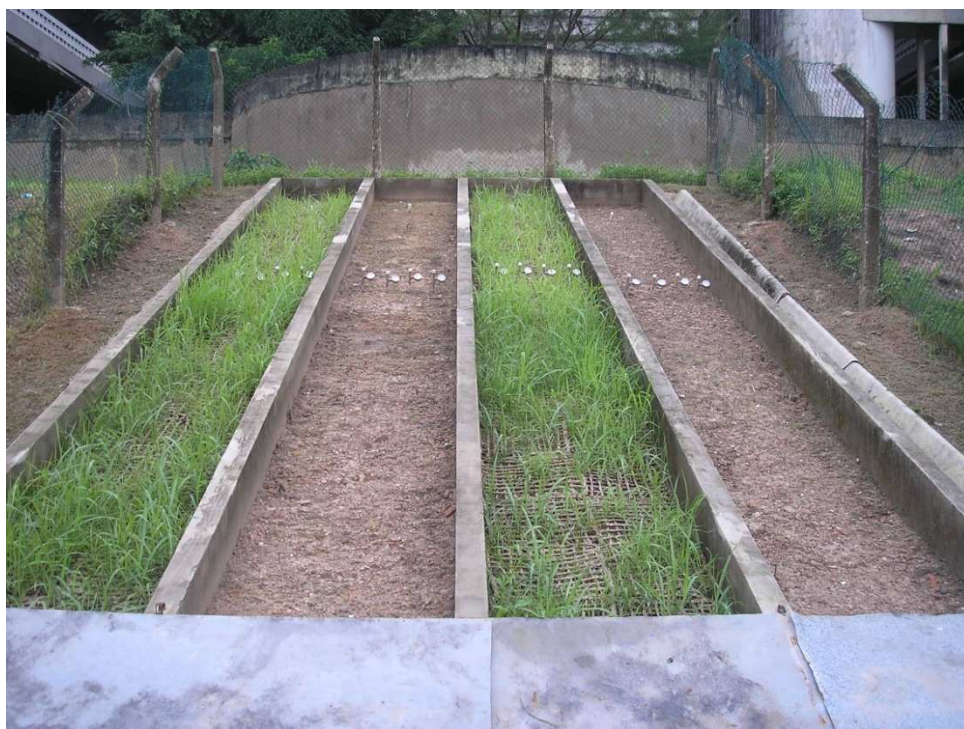
Figura 75 – Estação experimental com cobertura de gramíneas no dia 03 de março de 2009. Foto: Bezerra, 2009.
