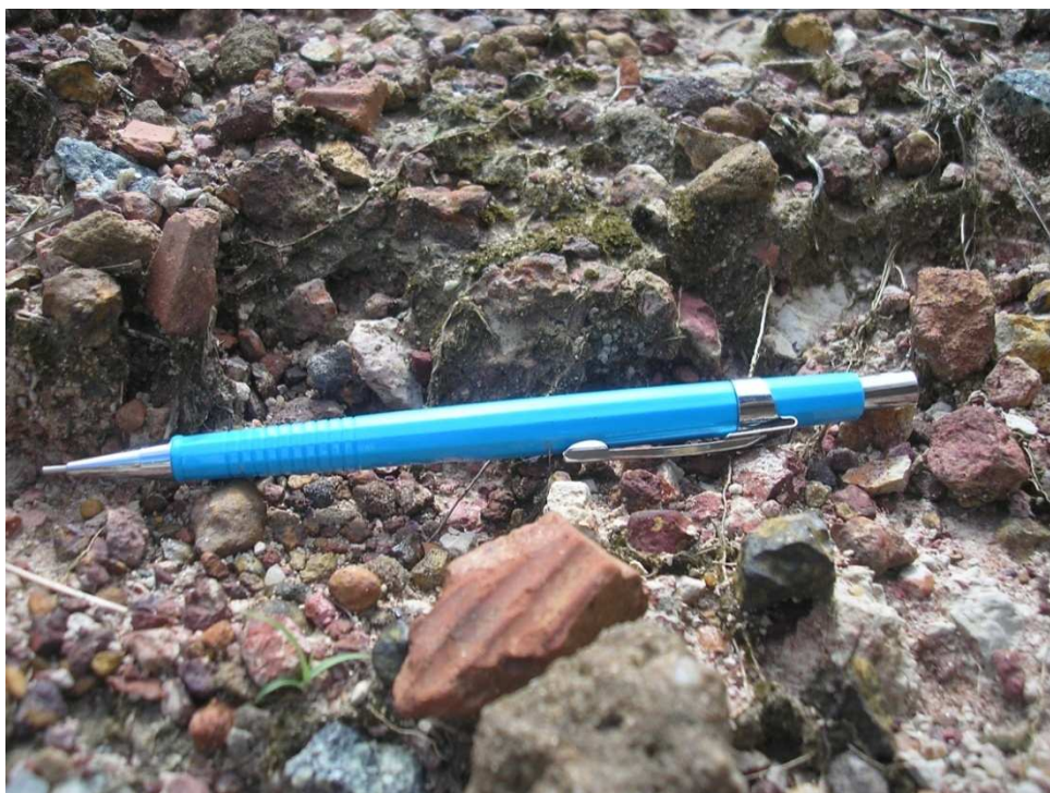
Figura 79 – Erosão diferencial, expondo as lateritas, na parcela com solo exposto b.
