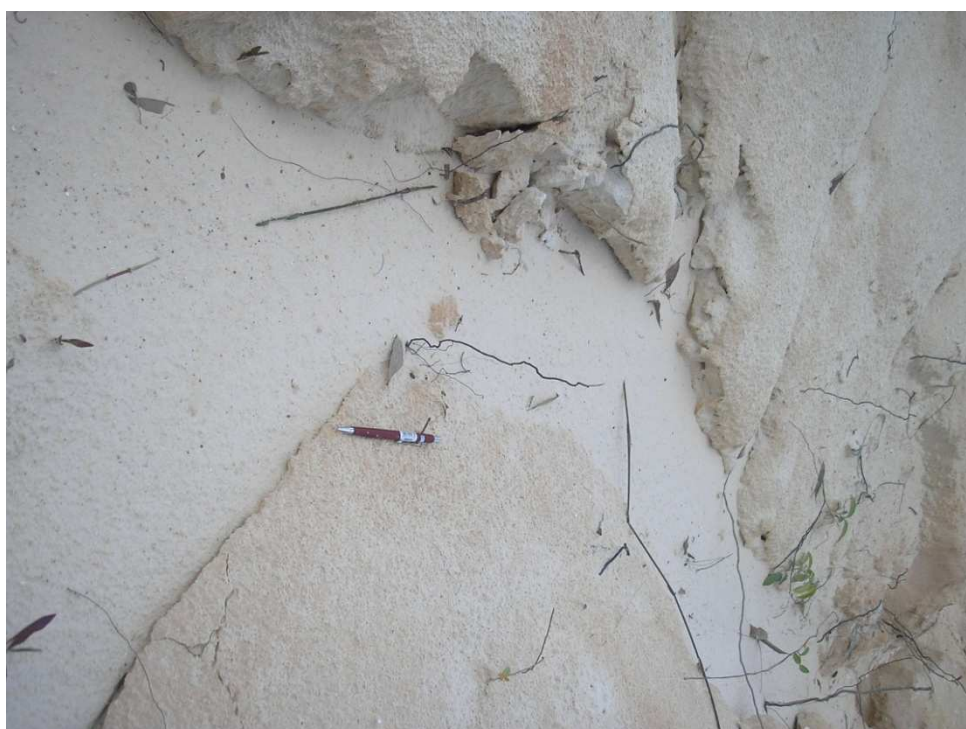
Figura 63 – Ravinamentos nas proximidades da voçoroca do Posto. Foto: Bezerra, 2009.
