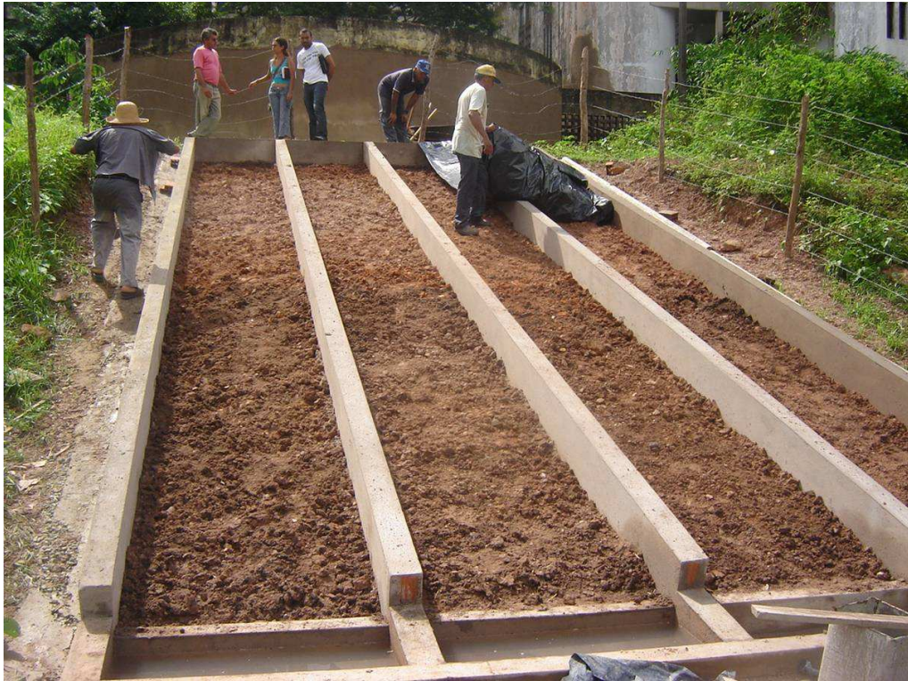
Figura 10 – Construção da estação experimental. Foto: Mendonça, 2006.
