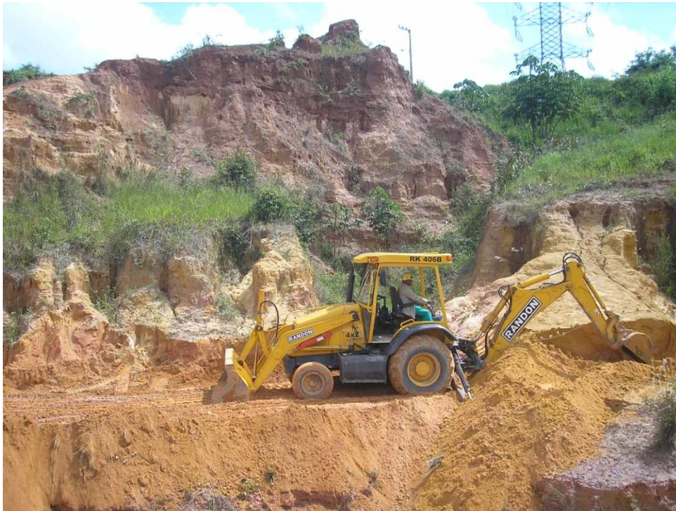
Figura 21 – Retaludamento da área com retroescavadeira. Foto: Bezerra, 2008.
