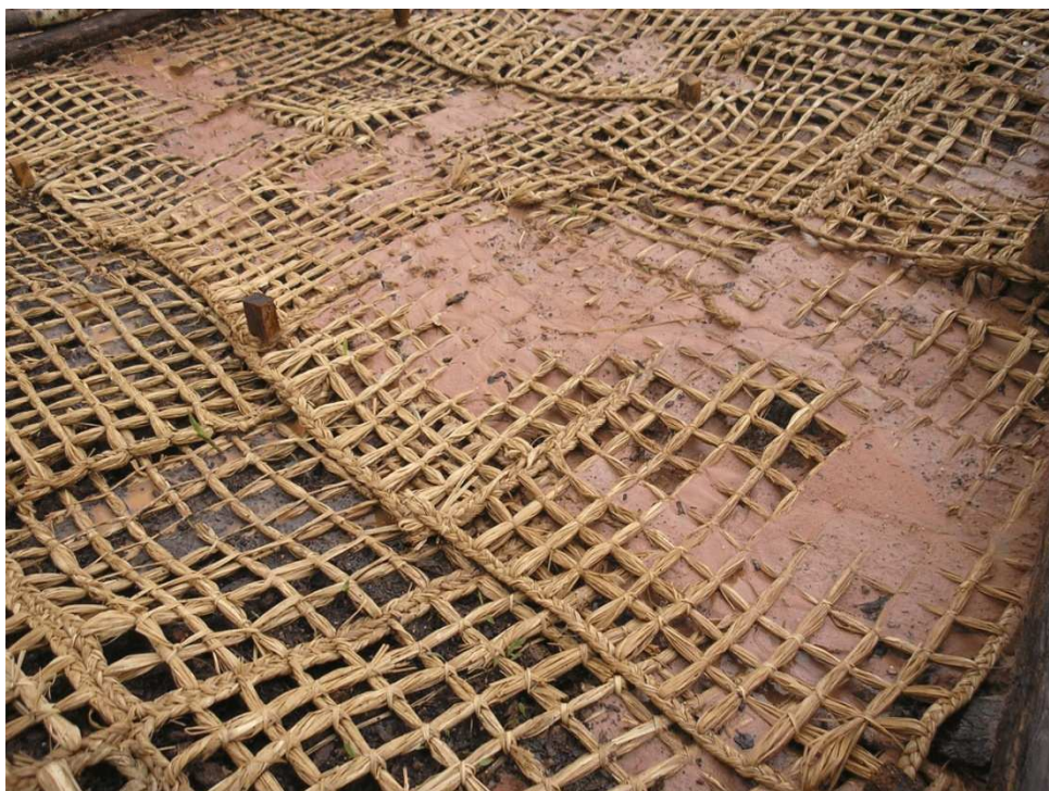
Figura 108 – Contenção dos sedimentos pelos geotêxteis na voçoroca do Sacavém.
