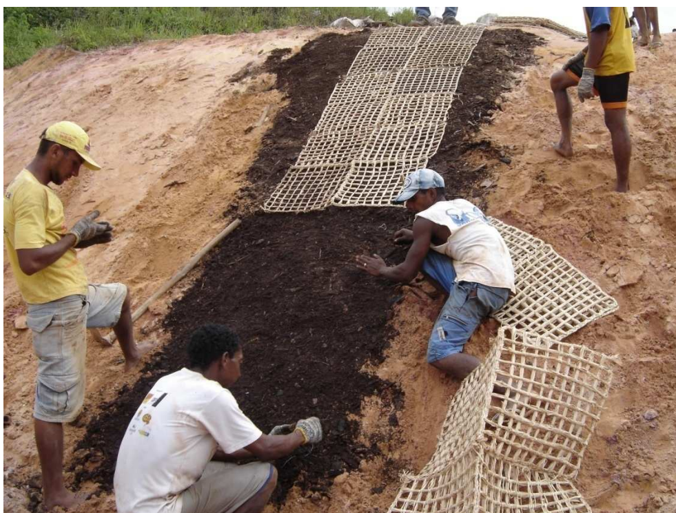
Figura 107 – Aplicação dos geotêxteis e insumos.
