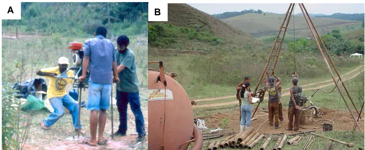
**Figura 44 - A) sondagem sendo feita com trado mecânico; B) sondagem por percussão (SPT).**
