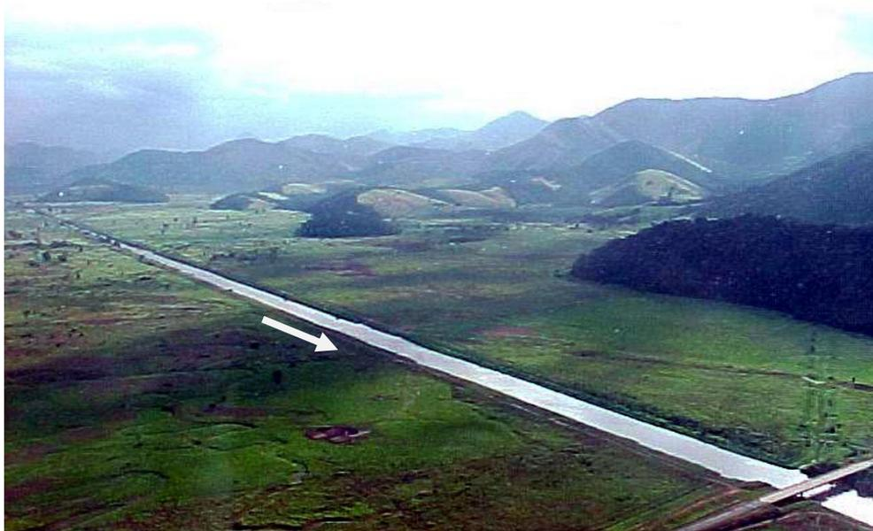
Figura 5-24: Trecho retificado do canal do rio Macaé. Fonte: Relatório Técnico EMUHSA 2007
