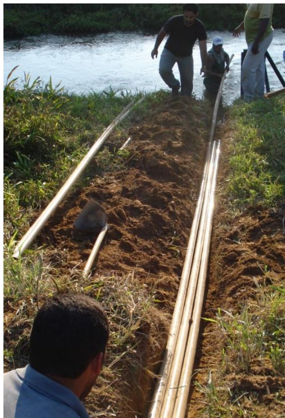
Figura 20: Instalação dos sensores
