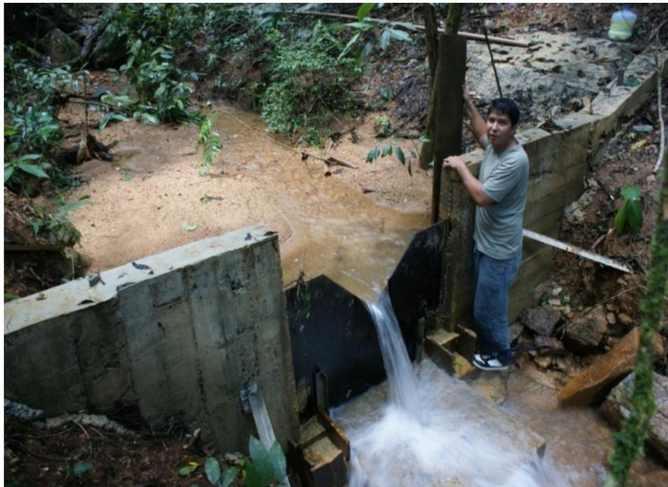
**Figura 5.3.2.9:** Evidência de completo assoreamento do vertedouro da bacia do rio da Solidão em abril de 2010.
