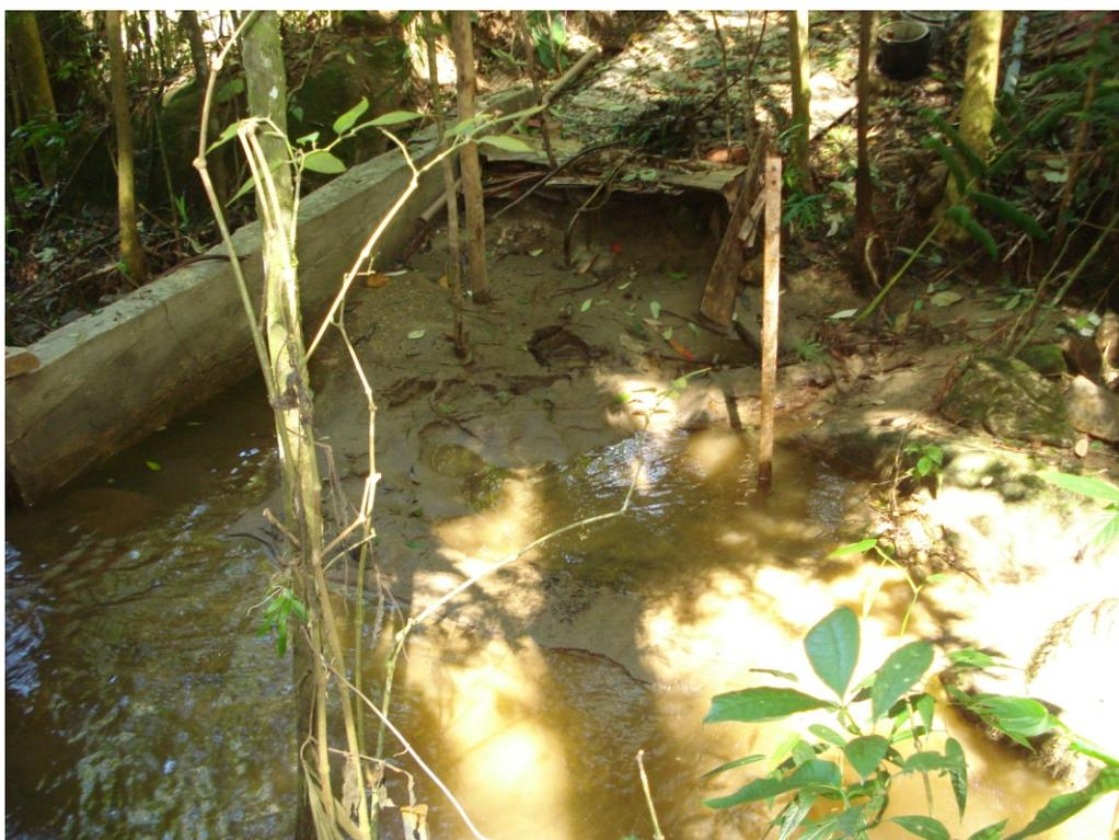
**Figura 5.3.1.9:** Assoreamento completo pós eventos de grande intensidade de abril de 2010 da estação fluvio –sedimentométrica da bacia laboratório do rio da Fazenda.
