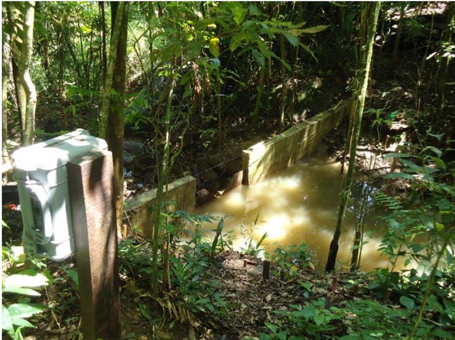
**Figura 4.3.2:** Estação Fluvio- Sedimentométrica da bacia do rio da Fazenda.
