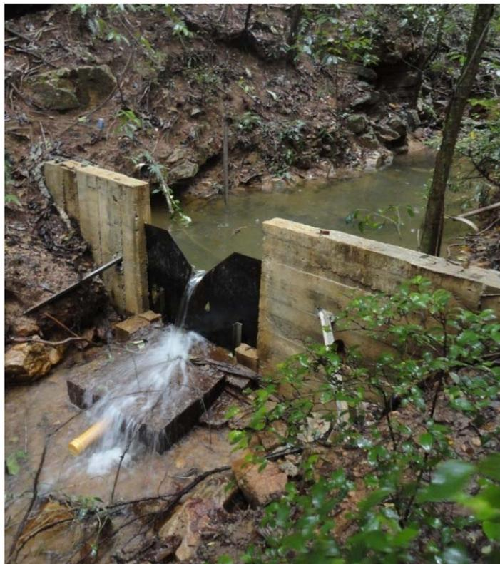
**Figura 4.3.1:** Estação Fluvio-sedimentométrica da bacia do riacho da Solidão.
