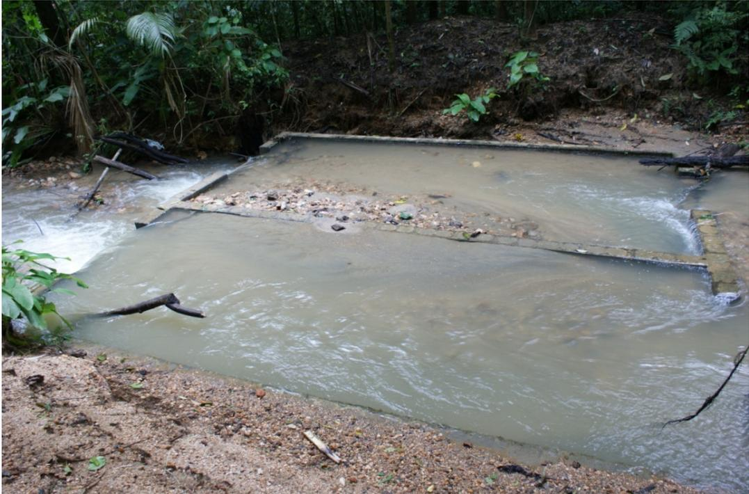
**Figura 5.3.2.13:** Assoreamento das caixas coletoras de sedimentos a montante do açude da Solidão.
