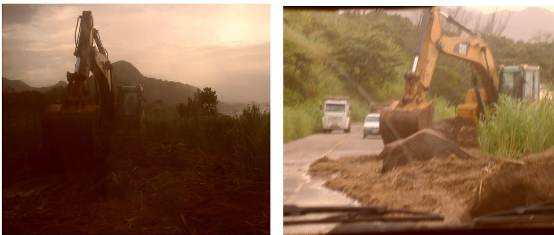
Figura 26. Máquinas trabalhando na liberação da pista após movimentos de massa de abril de 2010 (Fotos: Thiago Pereira, 2010).
