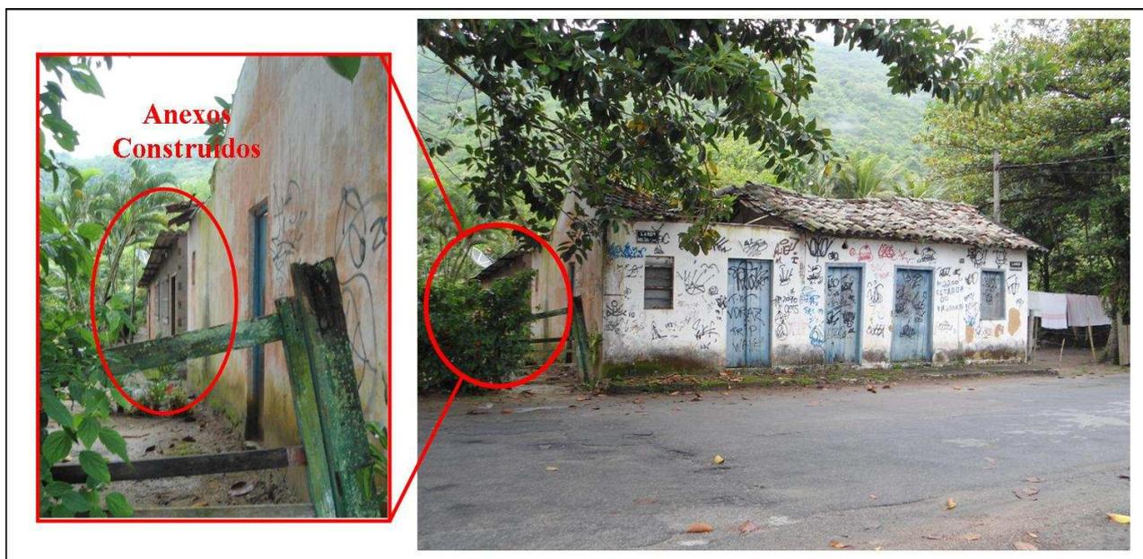
Figura 126. Ruína de antigo armazém localizada no Largo Francisco Caldeira de Alvarenga, utilizada no passado como residência e ampliada através da construção de anexos (Fotos: Thiago Pereira, 2011).
