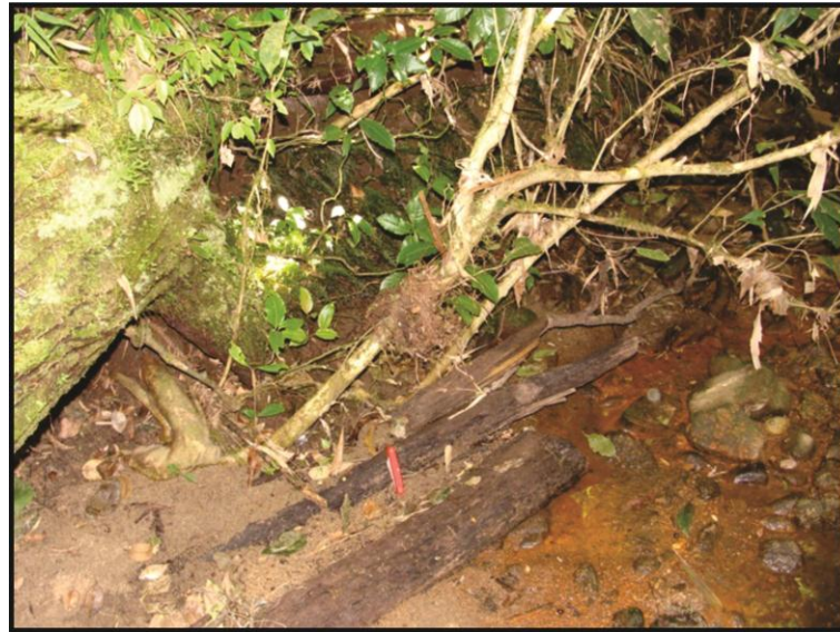
Figura 5.16 Arbustos de Myrciaria sp. na borda da calha, posicionada aproximadamente 50 m a jusante da seção S4. O fuste apresenta-se inclinado, com marcas de impactos e com acumulações de detritos, porém, o mesmo está firmemente fixo no substrato. Sentido do fluxo da esquerda para a direita. Fotografia de 04-04-2011. Canivete de escala.
