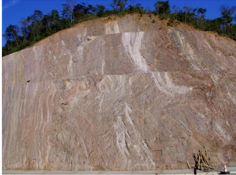
**Figura 70. Perfil de intemperismo de  $\approx$  20m de profundidade no xisto Nova Lima. Corte de estrada na rodovia Rio Acima-Nova Lima, Quadrilátero Ferrífero.**
