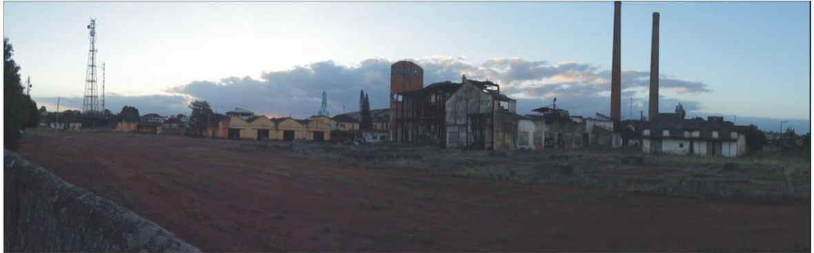
Usina de Capapebus abandonada. Fonte: Autor.
