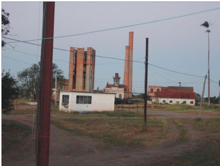
Usina de Quissamã, fechada desde 2002.
