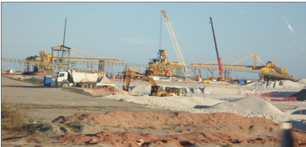
Obras de construção do Superporto do Açú. Fonte: Autor.
