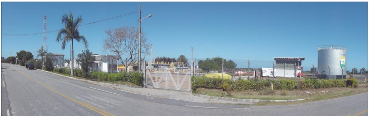
Instalações da Petrobras em Quissamã para purificação do petróleo da Bacia de Campos. Fonte: Autor.
