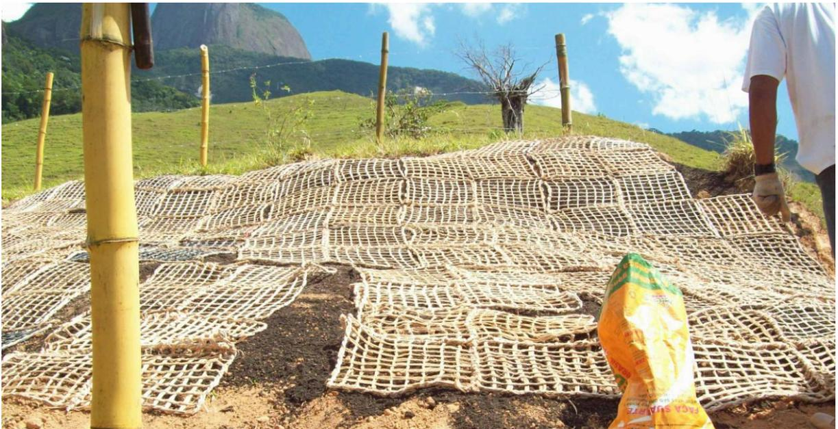
FIGURA 41. Fixação dos geotêxteis de fibra de bananeira na área em recuperação (Hugo Alves S. Loureiro, 2012).
