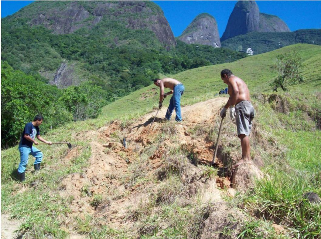
FIGURA 87. Retaludamento manual do trecho da encosta para recuperação (LAGESOLOS, 2012).
