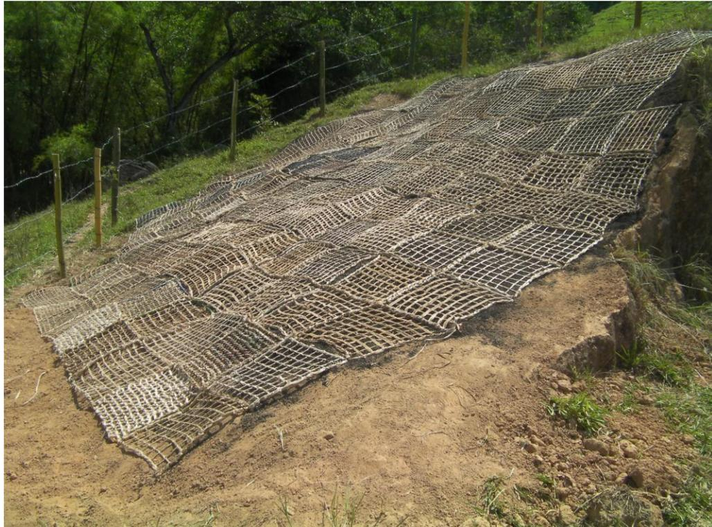
FIGURA 101. Visão lateral e próxima da área-teste de geotêxteis de bananeira, em 3 de março (José Fernando R. Bezerra, 2012).
