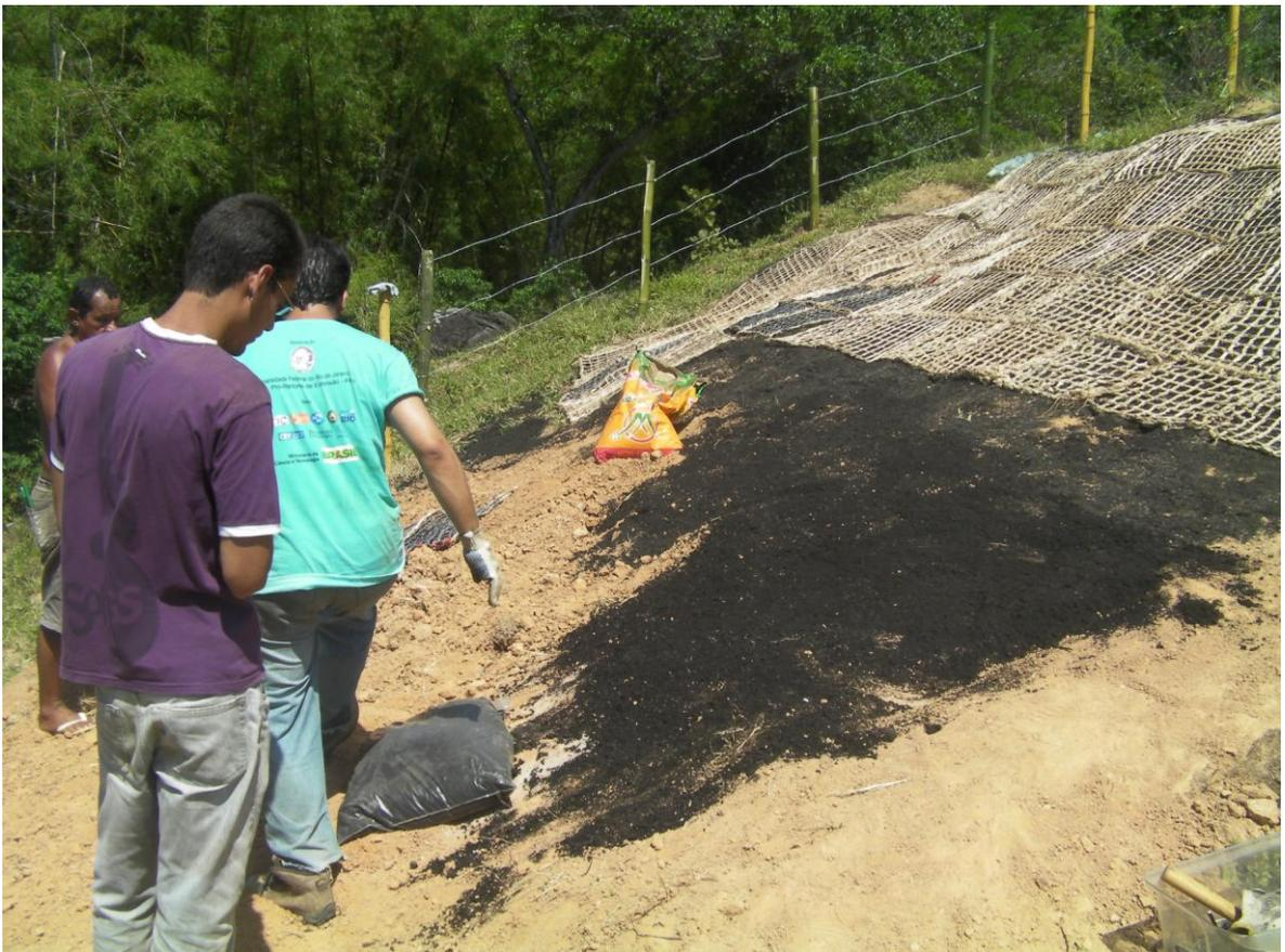
FIGURA 89. Aplicação de insumos, semeadura das sementes onde já havia insumos e instalação gradual dos geotêxteis, no dia 3 de março de 2012 (José Fernando R. Bezerra, 2012).
