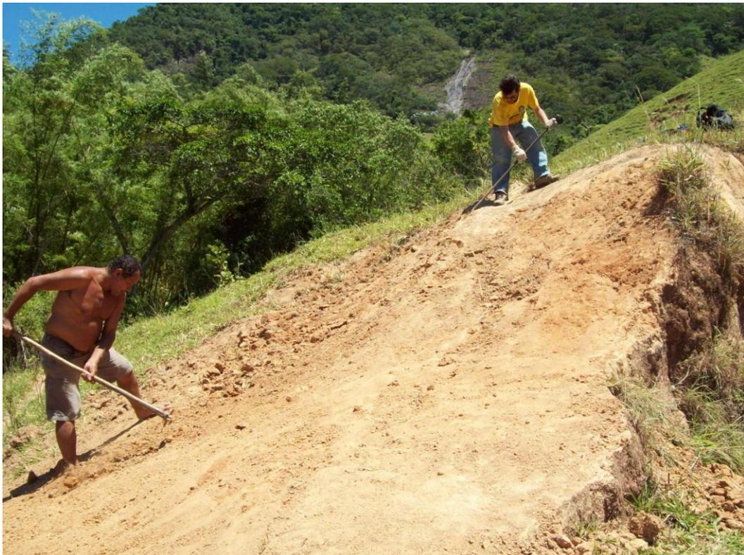
FIGURA 88. Resultado do retaludamento da encosta (LAGESOLOS, 2012).
