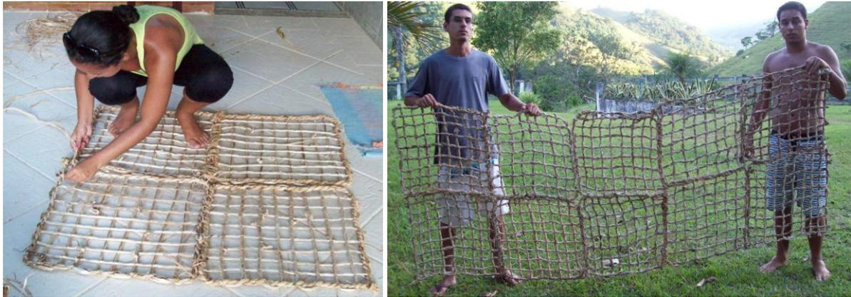
FIGURA 90. União de geotêxteis em grupos de quatro a até 10 telas em uma unidade inteira (Hugo Alves S. Loureiro, 2012).
