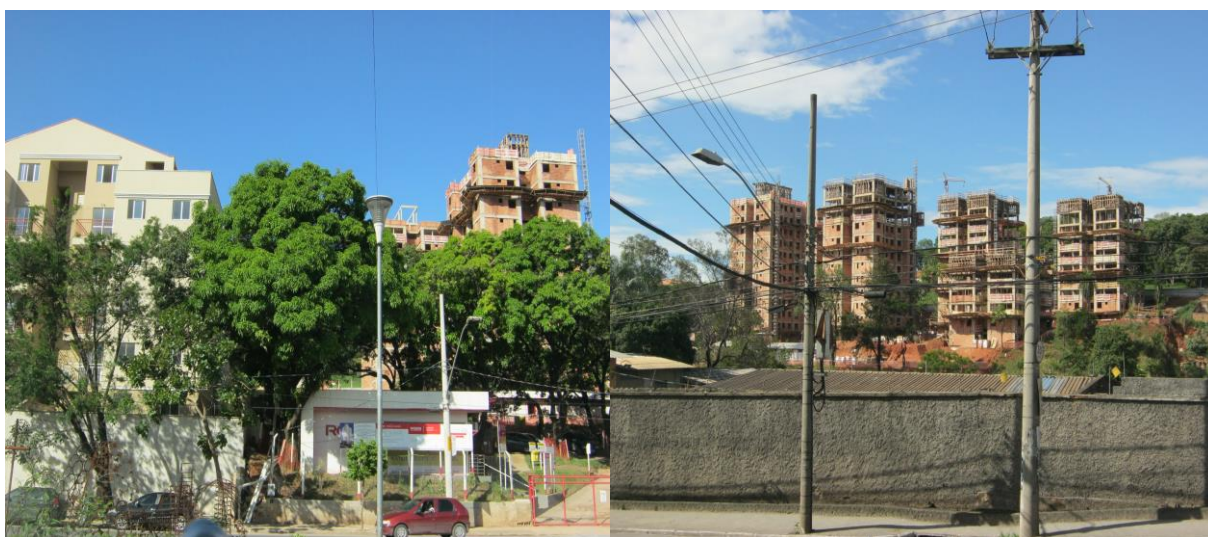
FOTO 14 – À esquerda: stand da ROSSI entre os seus empreendimentos à venda: de um lado o residencial Rossi Jardins Praças Residenciais pronto e do outro o residencial Rossi Mais Primavera em construção. À direita: vista pela Rua Padre Pedro Pinto dos edifícios do residencial Rossi Mais Primavera localizados na Avenida Vilarinho. Fonte: Ramon Coelho da Cruz, fotos de 11/2012.
