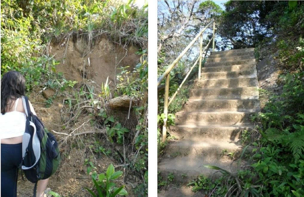
**Figura 33:** Movimento de massa e escada de cimento construída à montante do deslizamento. Acervo: L. A. Rangel, 2012.
