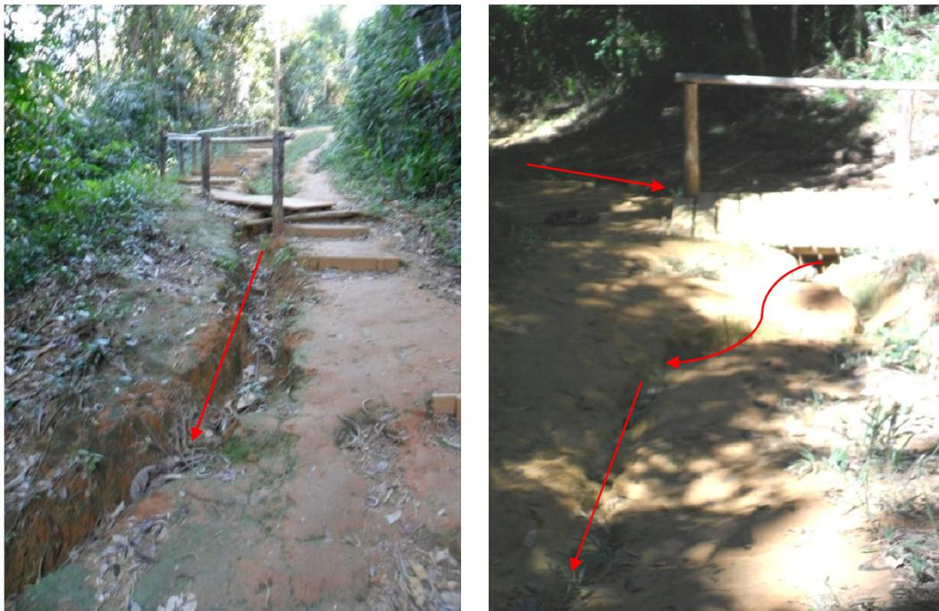
**Figura 31:** Escada e ponte em cima de ravina (destacado em vermelho) desenvolvida no leito da trilha. Acervo L. A. Rangel, 2012.
