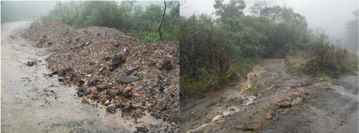
Figura 2. Material depositado no leito da Estrada e seu processo de remoção.
