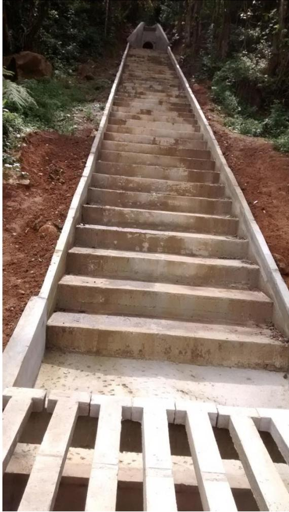
Figura 12. Escada para dissipação de energia de escoamento e bueiro. Fonte: Autor, 2014
