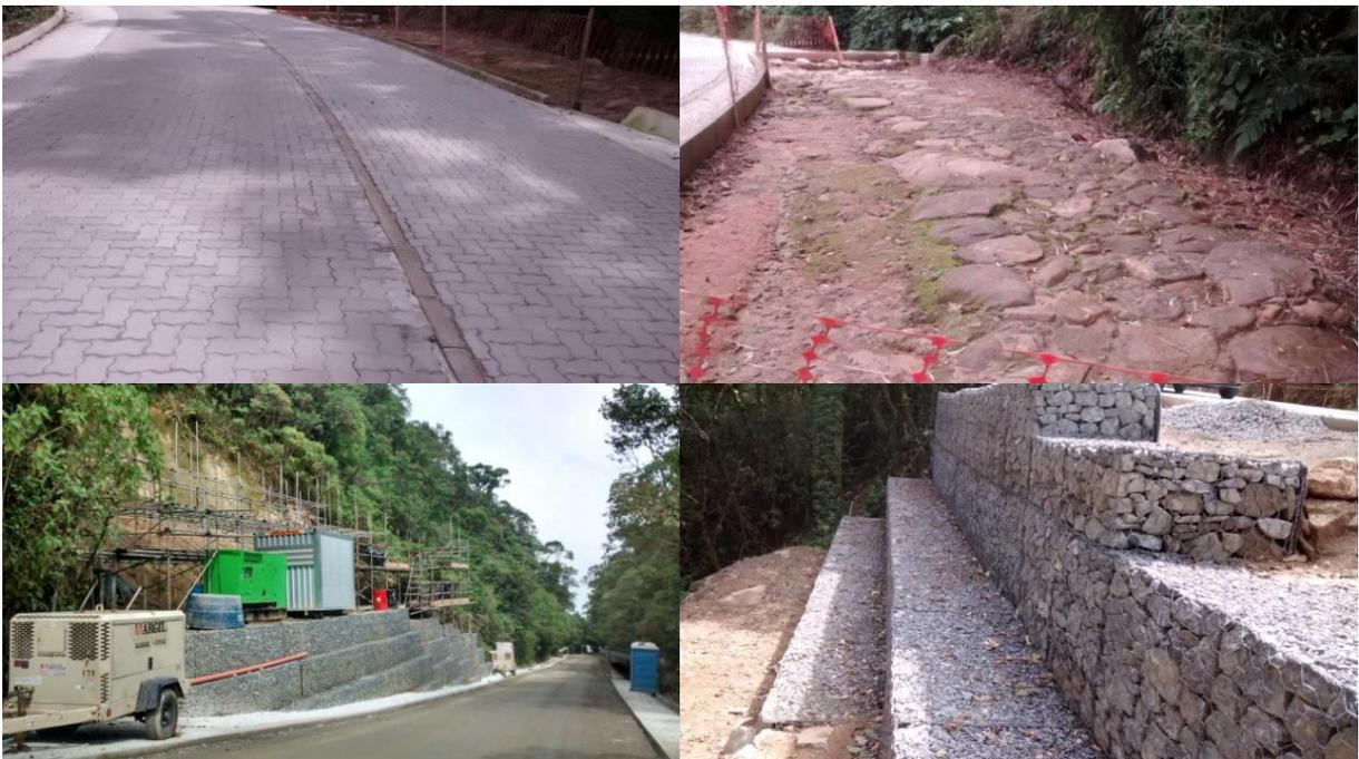
Figura 11. Calçamento da via com blocos intertravados (superior esquerda); Calçamento original da Estrada Real (superior direita); regularização do leito e muro de contenção (inferior esquerda); detalhe do muro de contenção (inferior direita). Fonte: Autor, 2014
