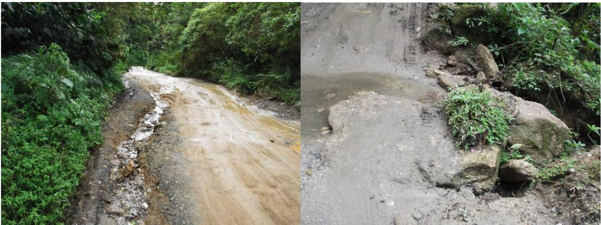
Figura 15. Degradação do leito da estrada. Fonte: Autor, 2012
